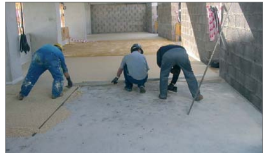
Regleado y compactado con llana
